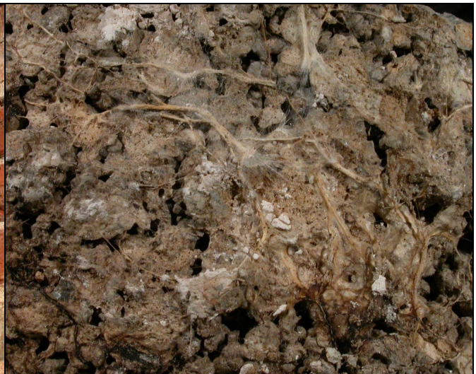
Abb. 6: Cremefarbene bis braune Stränge des Haus-Tintlings ( Coprinus sp.) durchwachsen eine kiesreiche Schüttung einer Zimmerdecke.
