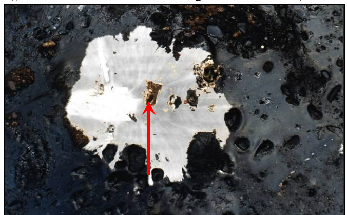
Abb. 2: Weißes, lappiges Mycel des Echten Hausschwammes durchdringt den Raum zwischen Teerpappe und Nagel. Selbst kleinste Ritzen werden auf der „Suche“ nach Nährstoffquellen durchwachsen (↑).
