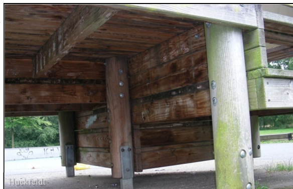
Abb. 1: Die innen liegende Unterkonstruktion ist vor holzerstörenden Pilzen geschützt (GK2), jedoch nur begrenzt vor Insekten und Bläupilzen; grüner Algenbewuchs nur in der GK3.1 und 3.2.
