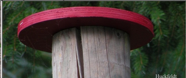
Abb. 12: Die Abdeckung schützt das Hirnholz und den Riss vor Niederschlägen.
