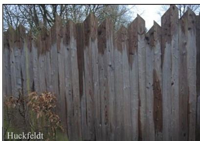
Abb. 6: Einfriedung ohne Abdeckung; obere Enden werden bei jedem Regen nass.
