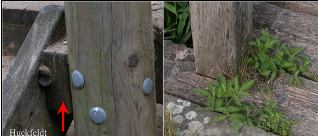
Abb. 11: Bauteil (↑) ist dreiseitig eingeschlossen; der Pilzfruchtkörper zeigt hohe Holzfeuchte an; rechts: Brücke: erdähnliche Bedingungen.
