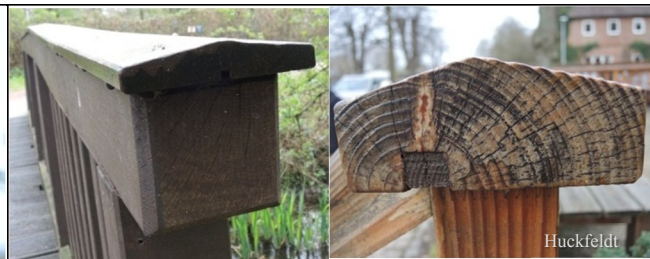
Abb. 8: Abdeckbrett schützt Oberseite vor der Witterung.
