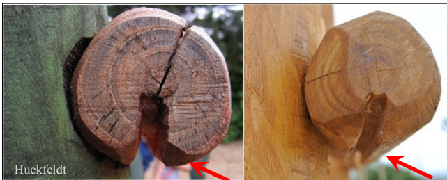
Abb. 7: Das einseitige Einschneiden von Rundhölzern auf der Unterseite vermindert die Rissbildung; zudem wurde Robinie als Holzart gewählt.
