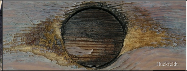
Abb. 14: Der Dübel quillt und schwindet anders als umgebendes Holz.
