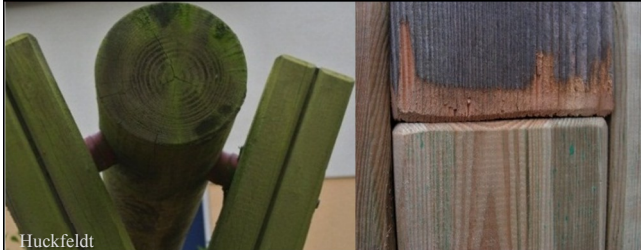
Abb. 9: Bauteil-Endkoppelung, zwischen Rundholz und Ständer; stumpfe Reparatur-Verbindung saugt ablaufendes Wasser wie eine Schwamm auf.
