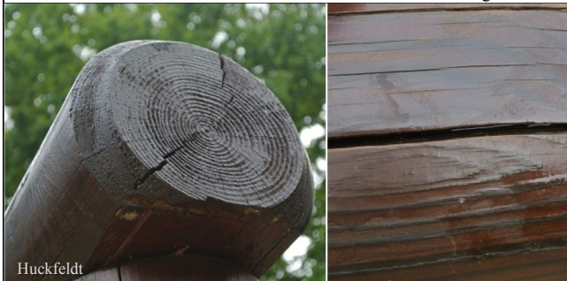
Abb. 15: Holz mit Markröhre hat oft Risse, in die Wasser laufen kann (↑); r: Aufsicht des Bauteils nach einem Schauer; in der Ritze steht Wasser.
