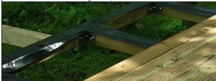
Abb. 5: Terrassenbau: Schutz der Tragkonstruktion mit aufgelegten Folien (Neopren oder Bleche werden empfohlen); am hellen Splintholz ist ein Bläuepilz-Befall schnell zu erwarten.
