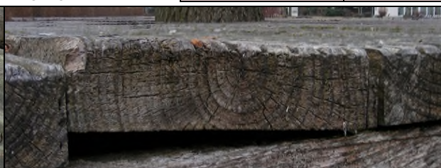
Abb. 2: Nicht herzogtrenntes Holz neigt zu Verwerfungen, an denen man sich mitunter den Zeh stoßen kann oder in Stolpern gerät.
