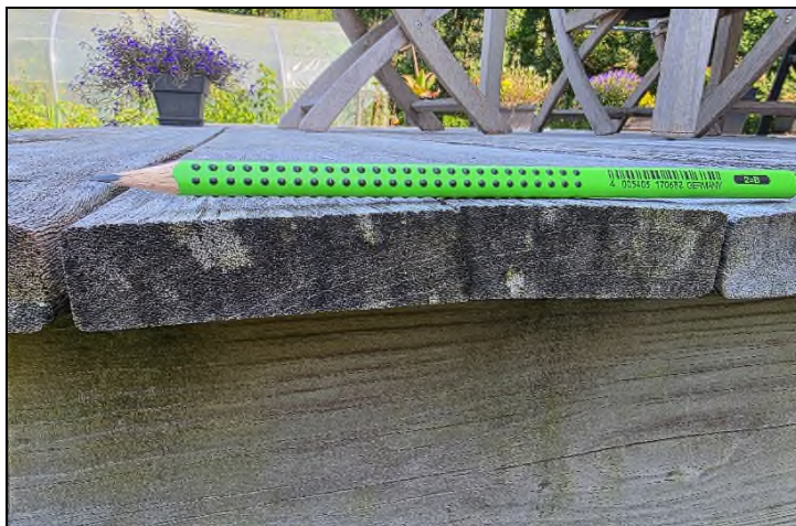
Abb. 11: Die Terrassen-Dielen, sollten so verlegt werden, dass sie bei Befeuchtung etwas nach unten „schüsseln“, so dass das Wasser besser ablaufen kann.
