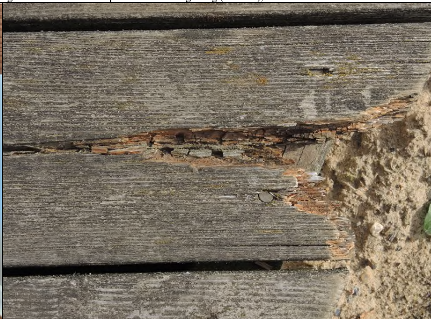
Abb. 16: Braunfäule-Schaden: Ein Erdkontakt des Holzes ist bei Terrassen zu vermeiden, da sich sonst Fäulepilze ansiedeln, die zu einer kurzen Lebensdauer der Bauteile führen können.
