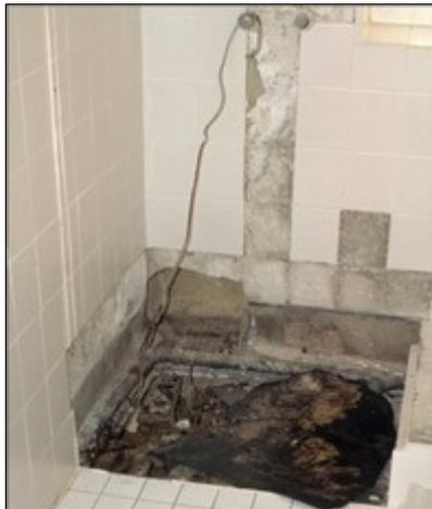
Abb. 4: „Eingepackte“ Konstruktionen im Bad mit Schaden durch Echten Hausschwamm; Mycel ist an der schwarzen Folie erkennbar. In diesen Fällen reichen kleine Wassermengen aus, um größere Schäden zu verursachen.
