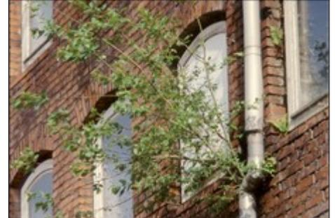
Abb. 2: Nasses Mauerwerk: Sicher ist eine Begrünung der Fassade wünschenswert, aber nicht so.
