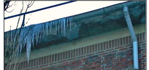
Abb. 1: Gestörter Wasserabfluss: Wasser kann ins Mauerwerk eindringen; die Bedingungen für das Wachstum des Hausschwamms werden geschaffen.
