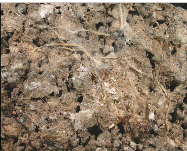
Abb. 6: Cremefarbene bis braune Stränge des Haus-Tintlings ( Coprinus sp.) durchwachsen eine kiesreiche Schüttung einer Zimmerdecke. Befallsort: Einschub eines Holzfußbodens im 3. OG.
