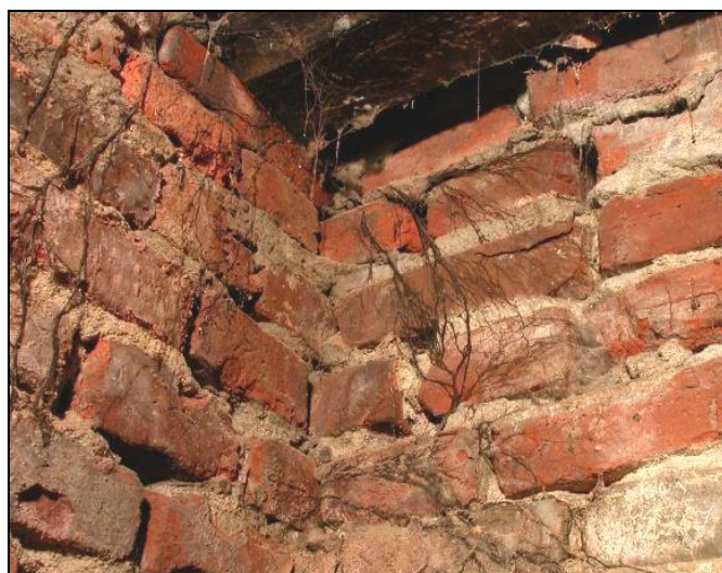
Abb. 5: Häufiges Bild: Dunkle Stränge des Braunen Kellerschwammes ( Coniophora puteana ) wachsen am Mauerwerk und durchwachsen es. Befallsort: Kriechkeller unterhalb eines Holzfußbodens.
