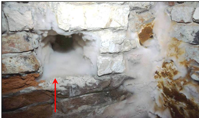
Abb. 1: Weißes, wattiges Mycel des Echten Hausschwammes im Mauerwerk (↑); die im Mauerwerk wachsenden Stränge versorgen die zimtbraunen Fruchtkörper (rechts). Es sind Angst- oder Notfruchtkörper, die während einer Sanierung auftraten und ein sicheres Zeichen für einen aktiven Befall sind, also ein wachsender / vitaler Schwamm vorliegt.
